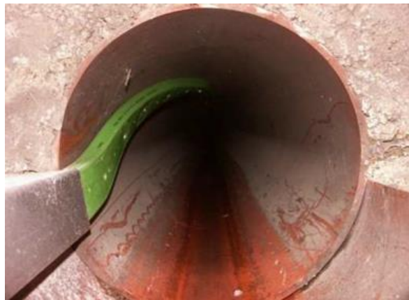
Рисунок 32 – Прокладка микротрубочной канализации с помощью крепежа
