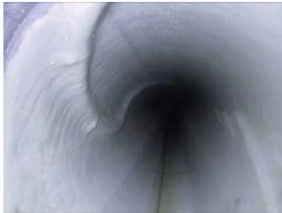
Рисунок 31 – Прокладка микротрубочной канализации с помощью полимерно-тканевого рукава при санации
